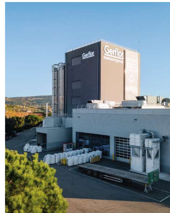
↑ Usine Dalles et Lames, Saint-Paul-Trois-Châteaux, France.
